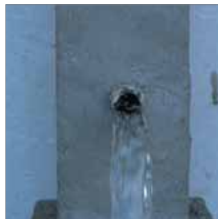
Impermeabilizar el soporte.
