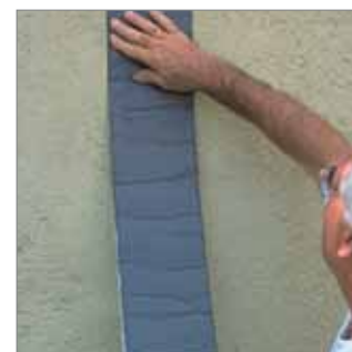
Colocar presionando fuertemente.
