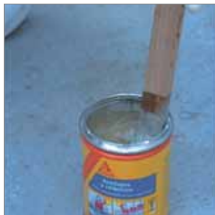
Homogeneización de la mezcla.
