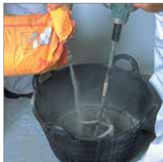
Vertido del producto sobre el líquido/amasado o agua de amasado.
