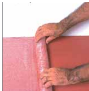
Una vez aplicada la 1.ª mano, se coloca de la armadura de tejido de vidrio, Armafill.
