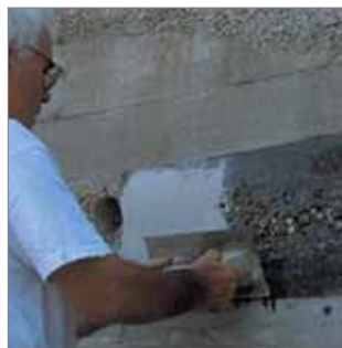
Aplicación del producto sobre imprimación fresca.
