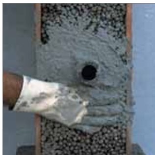
Recoger el agua por un tubo de drenaje fijado con un mortero rápido.
