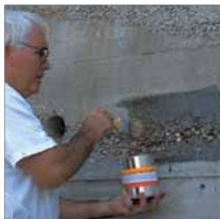
Imprimación con Sikafloor®-156.
