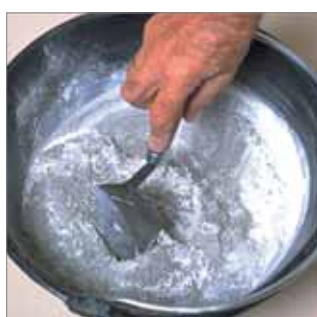
Mezcla del cemento y el aditivo.
