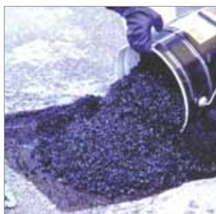
Vertido del producto sobre la imprimación fresca.
