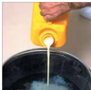
Mezcla del aditivo y el agua.
