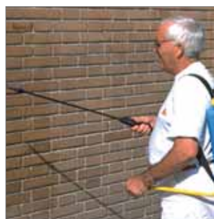
Si se desea se puede hacer una aplicación de manera mecánica (con una sulfatadora p.ej.)
