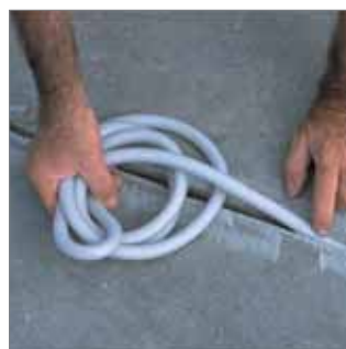
Colocación del Fondo de Junta Sika.
