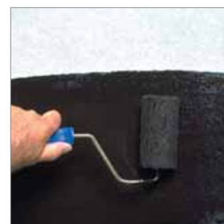
Imprimación con el producto diluido (10-20% de agua).
