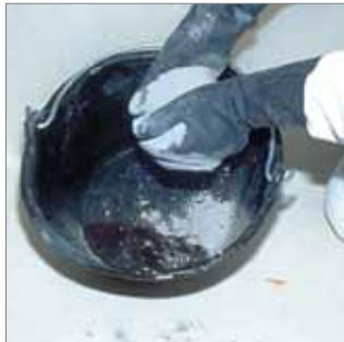
Vertido del cemento.
