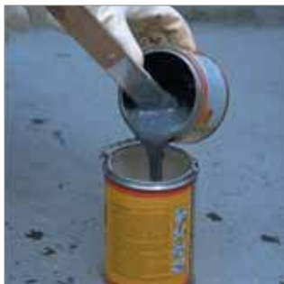
Vertido del componente B sobre el A.
