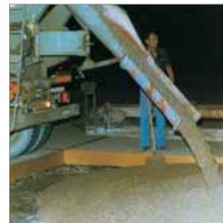
Vertido del hormigón fresco (antes de que la resina de unión haya endurecido totalmente).
