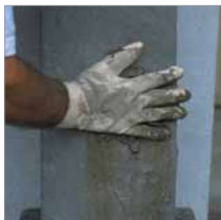
Taponar la vía de agua.
