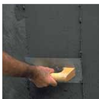
Aplicación de la primera mano con llana.
