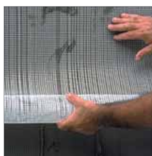
Colocar la malla antialcalina, (opcional).
