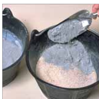
Se añade a la mezcla la arena de río.
