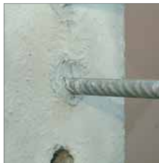
A la hora ya ha endurecido suficientemente la resina.
