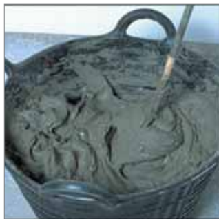
Homogeneización de la mezcla.
