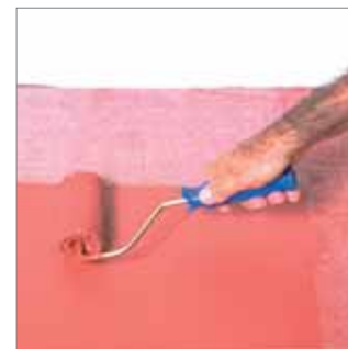
Aplicación de las siguientes capas.
